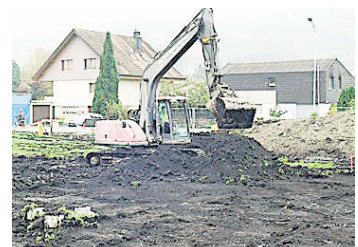
Bagger beim Oberboden-Abtragen.
